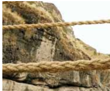
Figura 1.5 Funi usate dagli Inca per realizzare un ponte sospeso.
