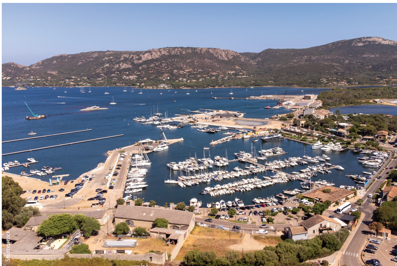
Porto-Vecchio Situato sulla costa SE della Corsica, questo porto richiede attenzione nella fase di accesso a causa dei banchi sabbiosi e rocciosi che costellano l'area di avvicinamento. Attualmente sono in corso lavori di ampliamento del porto (vedi p. 180).
